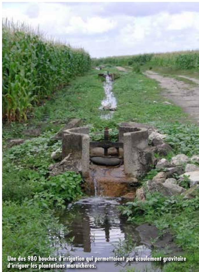
Une des 980 bouches d'irrigation qui permettraient par écoulement gravitaire d'irriguer les plantations maraîchères.
